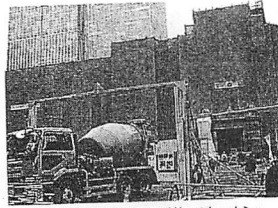
都心部での需要増でセメント販売は底入れ感が出ている(工事中のJR東京駅)
