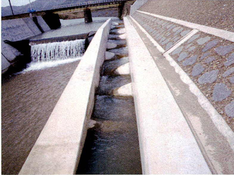
Photo2 鳥羽川 三田頭首工
