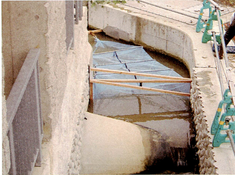
Photo6 足羽川 足羽川頭首工
