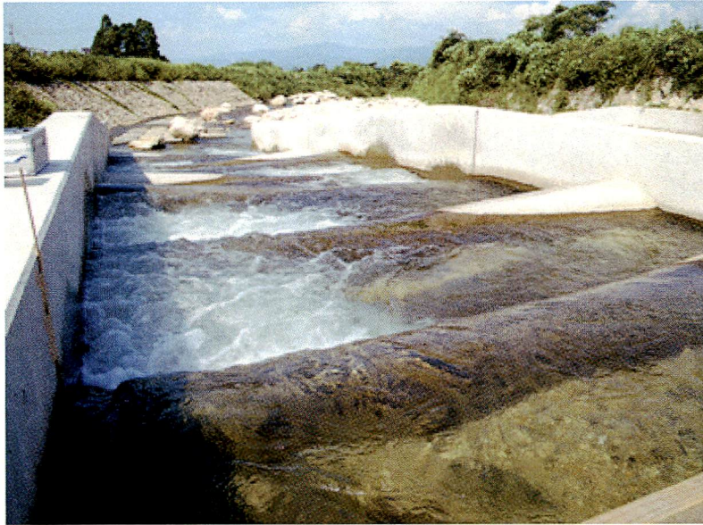
Photo5 黒河川 山頭首工
