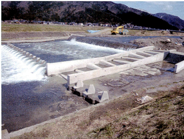
Photo1 北川 三宅頭首工
