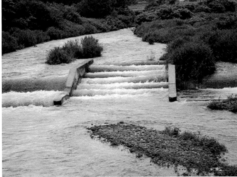
Photo4 日野川 大門頭首工
