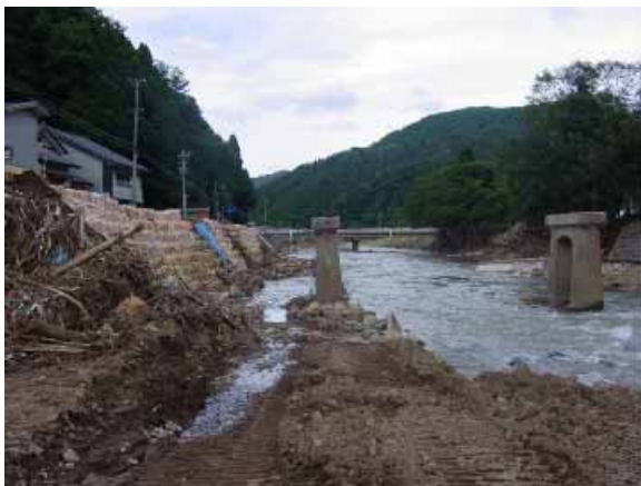
河原橋の橋桁と護岸の流出 (美山町西河原)
