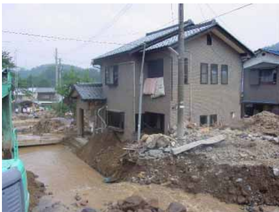
土石流による住宅被害 (美山町蔵作)
