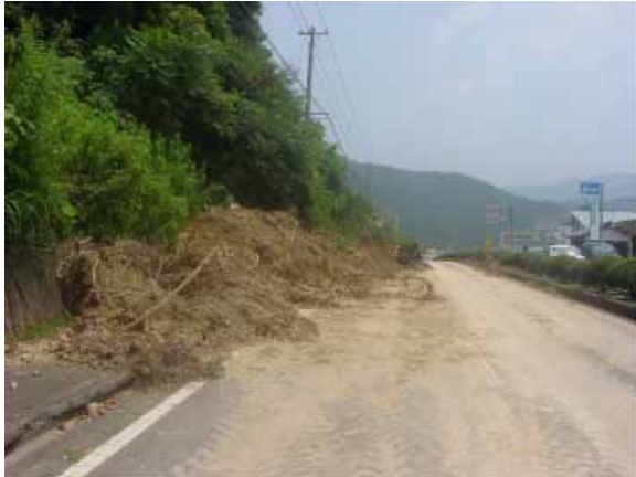
国道 158 号線の斜面崩壊 (福井市前波町)
